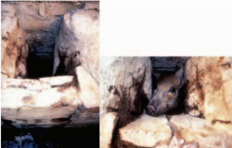
FIGURA IV.7. Letrina construida ex profeso para que los cerdos ingieran la materia fecal. Un cerdo se asoma por el conducto del asiento.
