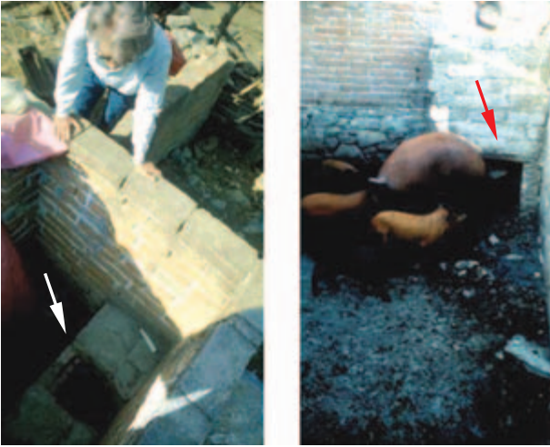
FIGURA IV.6. Letrina construida ex profeso para que los cerdos ingieran la materia fecal. (Flecha blanca: asiento; flecha roja: salida de la material fecal para los cerdos.)
